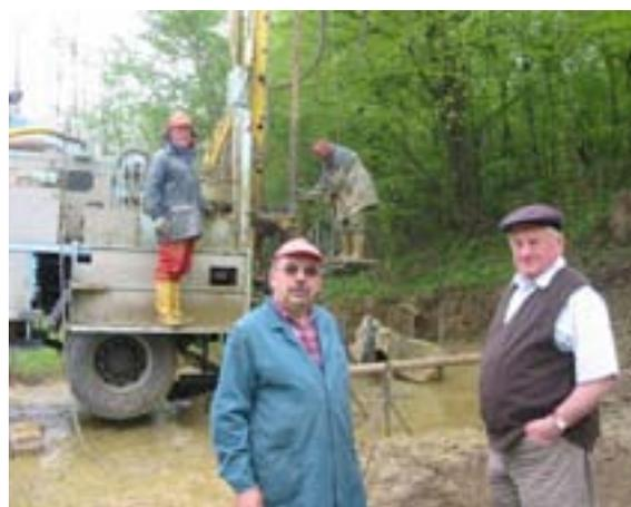
Der neue Brunnen wurde von der Fa. Reiter auf eine Tiefe von 38 m gebohrt und auf 34 m ausgebaut. Die Ergiebigkeit des Brunnens beträgt ca. 150 l/min. und die 1. Probe war sehr viel versprechend. Es wurde bereits die Verbindungsleitung zum alten Brunnenkopf verlegt, eine neue Unterwasserpumpe eingesetzt und ein Dauerpumpversuch unternommen. Die Kosten für die Bohrung incl. Ausbau des Brunnens betragen ca. Euro 8.000,-.
