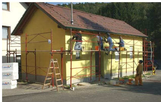
Links ist das Gebäude noch als früheres Kühlhaus erkennbar. Rechts bereits nach Isolierung durch Kleben von Styropor beim Anbringen des Fertigputzes, es folgten später nur mehr die Malerarbeiten und die Stiege sowie Pflasterung rund um das Gebäude im Außenbereich.
