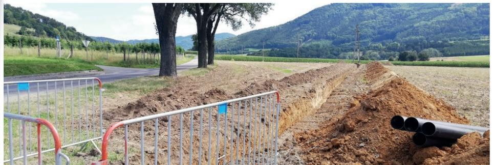
Breitbandausbau in der Marktgemeinde: Mit Glasfasertechnologie erreicht man eine ultraschnelle und stabile Datenverbindung mit Bandbreiten von bis zu 1.000 Mbit/s.
